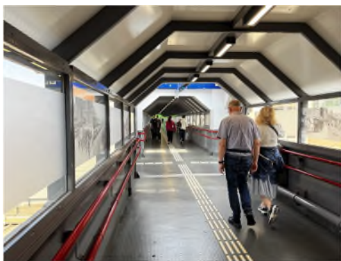
Figuur 5 foto van de huidige passerelle
